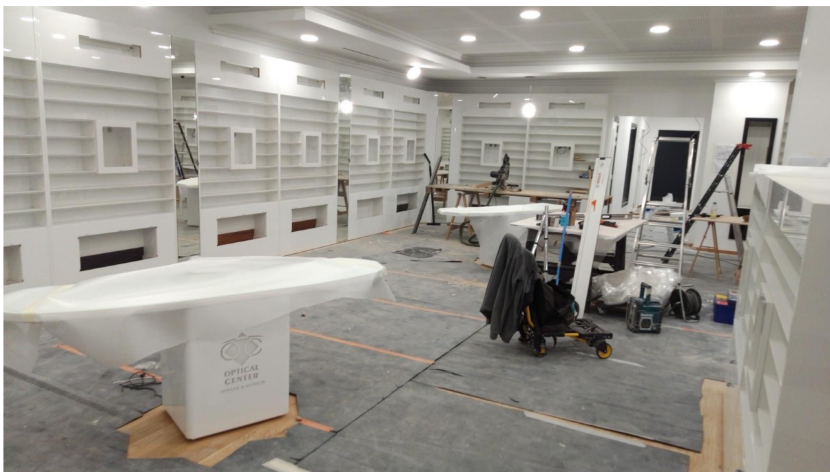
Montage en atelier et pose d'un magasin Optical center
