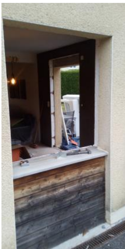
Changement et pose de fenêtres
