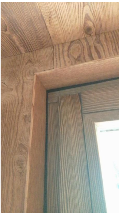
Pose de bardage mural et plafond, encadrement de fenêtres
