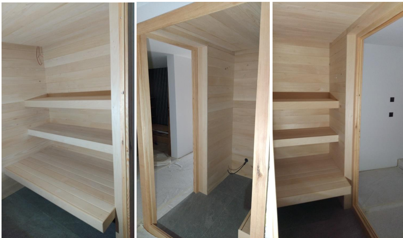
Construction d'un sauna
